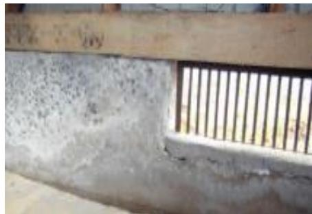
劣化してひび割れたコンクリート基礎
