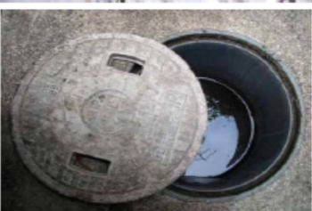
マンホールの中
